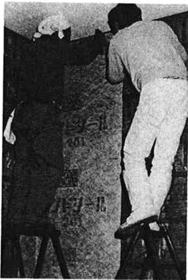
写真1 一般住宅でのサウンドシール施工時の模様
