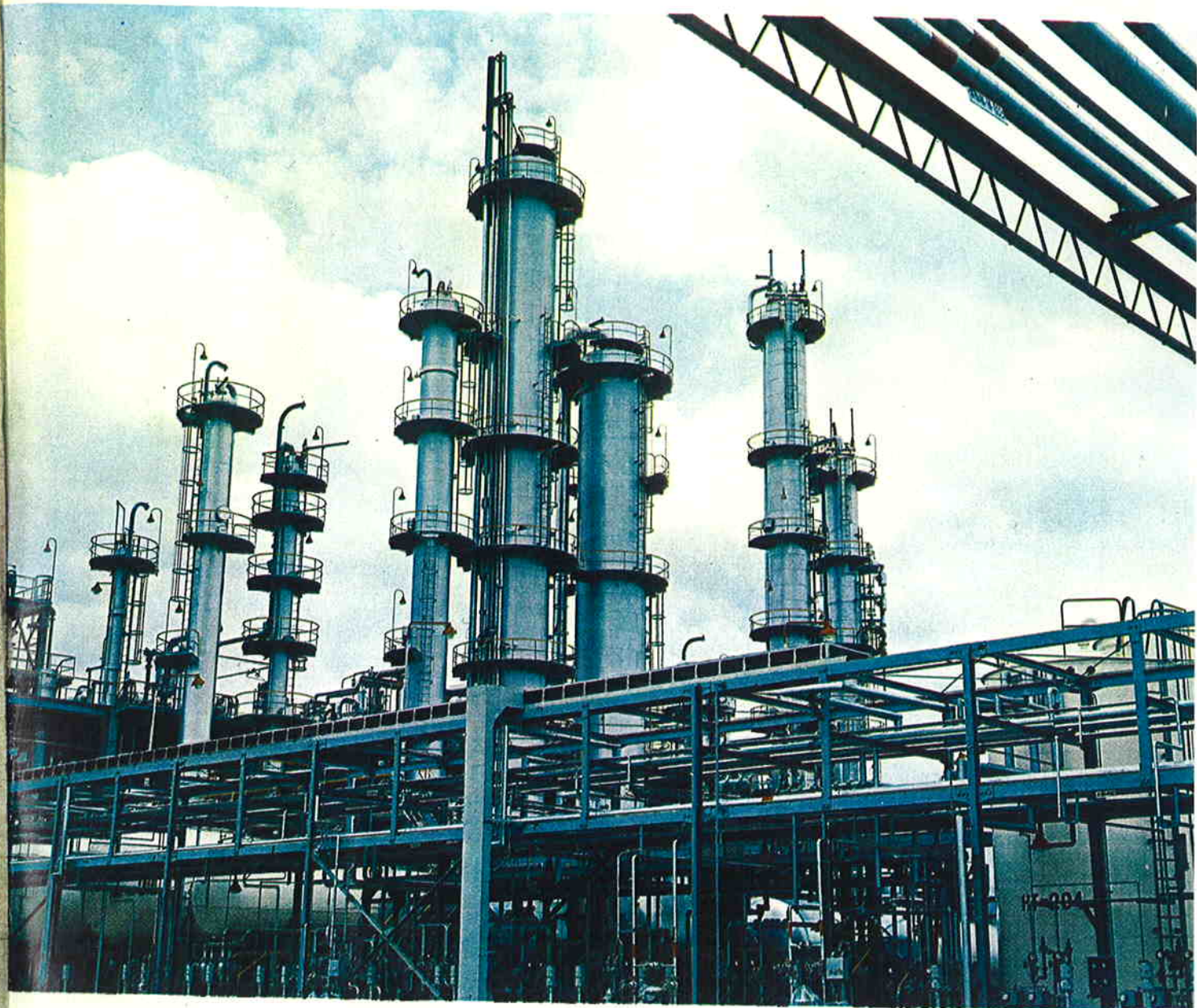
塩化ビニールモノマーの増設プラント完成
