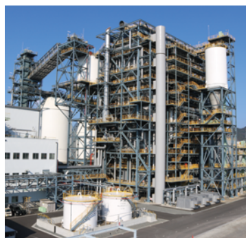
バイオマス発電所
