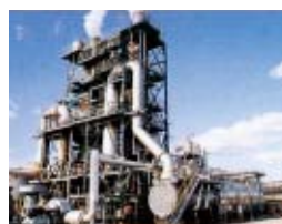
臭素リサイクル設備
