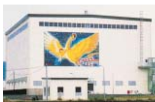
周南市ごみ燃料化施設
