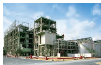
MDI製造設備
