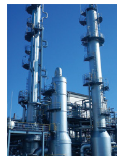
CO 2 回収および原料化設備
