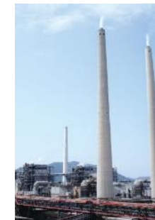
自家発電設備
