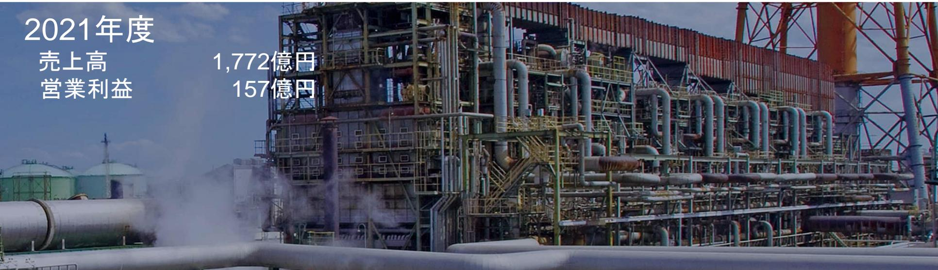
ナフサを分解してエチレン、プロピレンをはじめとした石油化学の基礎原料や、ポリエチレン、合成ゴムなどの誘導品を生産
