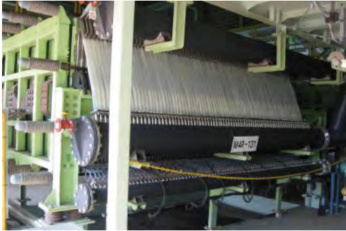
苛性ソーダの新型電解槽
