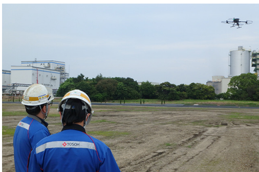
ドローンによる高所外観点検
