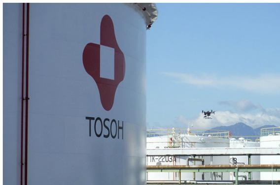
ドローンの導入による高所外観点検
