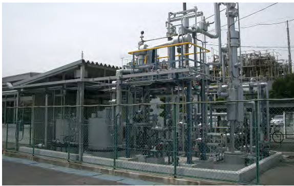
トレーニング実習設備
