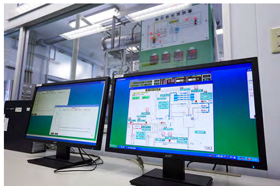
プラント実習設備
