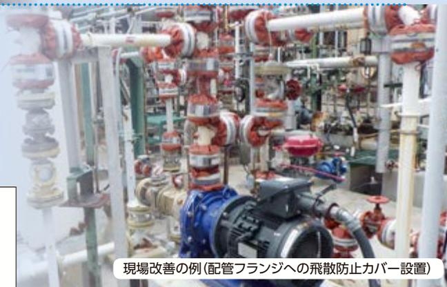
現場改善の例(配管フランジへの飛散防止カバー設置)
