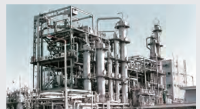
クロロブレンゴムプラント(1966)
