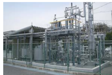
トレーニング実習設備
