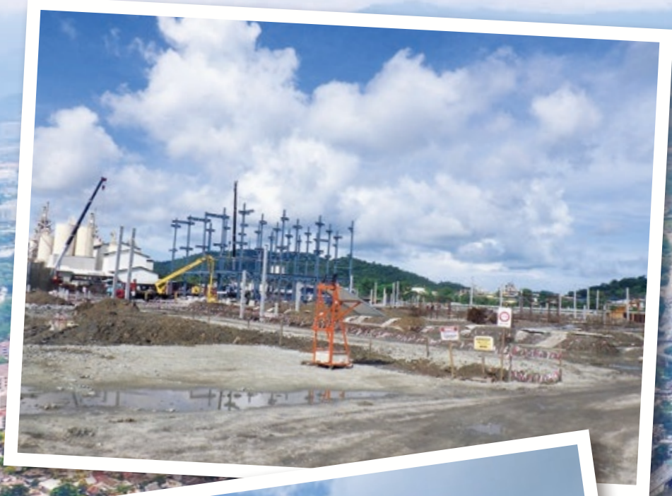
建設中のマレーシア工場
