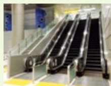
エスカレーター手すり
