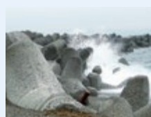
波消しブロック
