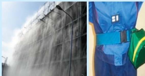
プラント建屋の水カーテン
