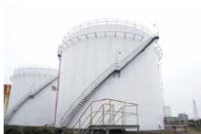
浮き屋根式タンク★全景
