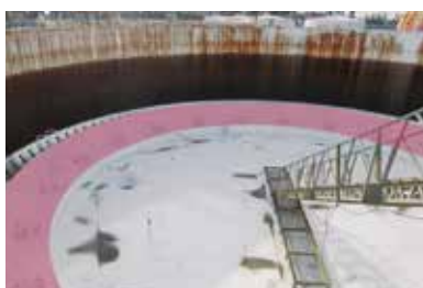
改修後の浮き屋根式タンク上部
