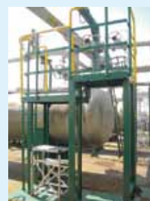
設置した高所操作架台
