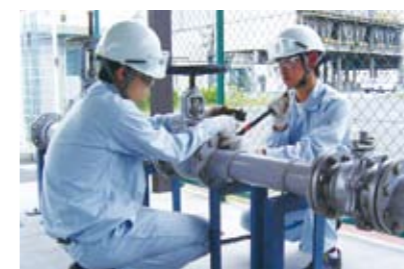
大型配管の復旧作業教育
