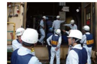
安全特別パトロール現場確認状況
