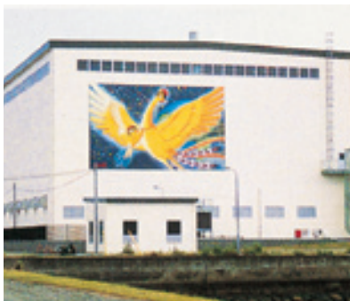
周南市ごみ燃料化施設
