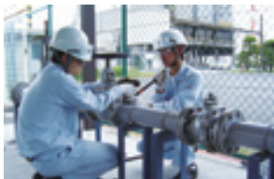
大型配管の復旧作業
