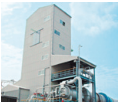
副生塩回収設備
