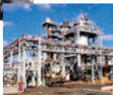
塩素リサイクル設備
