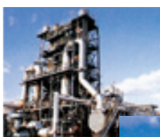
臭素リサイクル設備
