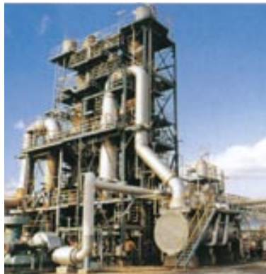
臭素リサイクル設備
