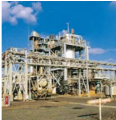
塩素リサイクル設備
