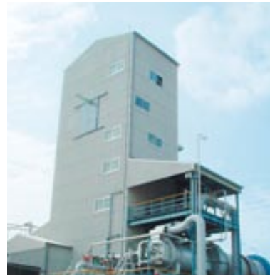
副生塩回収設備
