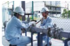
大型配管の復旧作業
