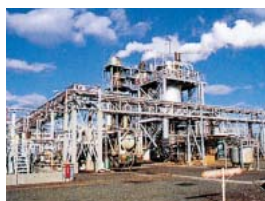
塩素リサイクル設備
