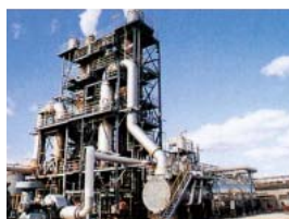
臭素リサイクル設備
