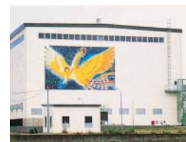
周南市ごみ燃料化施設
