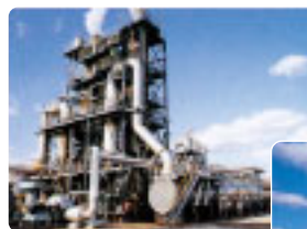
臭素リサイクル設備
