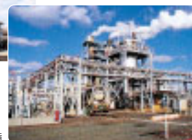
塩素リサイクル設備
