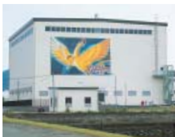
周南市ごみ燃料化施設 フェニックスすなわち不死鳥のイメージは「再生」と「新しい生命」です。
