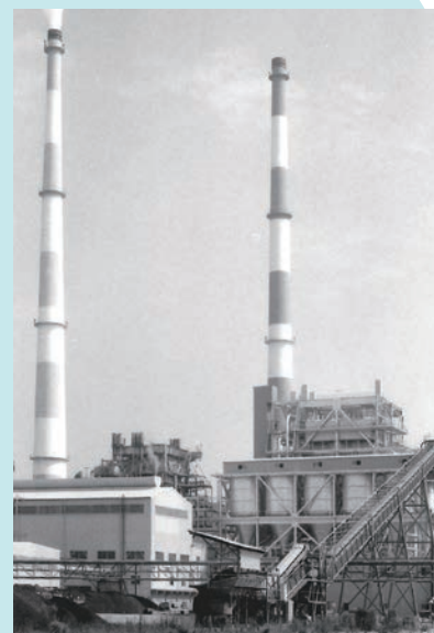
1982年完成の大型石炭ボイラー
