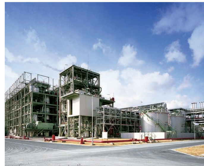
2007年完成のMDI(8M)プラント
